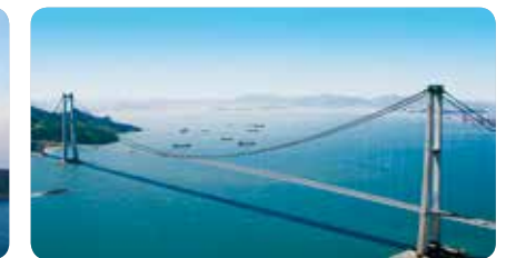
吊り橋 (李舜臣大橋)
