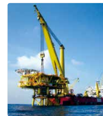
起重机 / 锚缆 / 系泊绳
