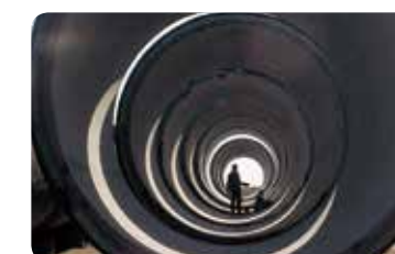
预应力钢管混凝土管
