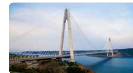
斜拉-悬索混合桥 [苏丹塞利姆大桥 - 博斯普鲁斯3号大桥]
